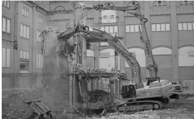
Démolition du dernier tronçon des galeries en terrasses. Photo : Kareem El-Khatib
